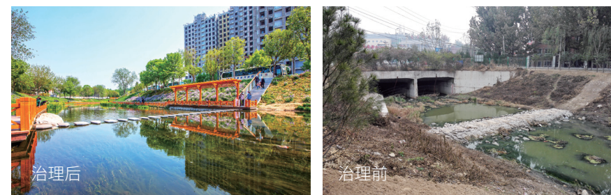
新风河台湾街暗涵出口
