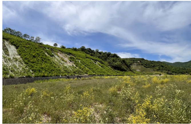
门头沟区王平镇吕家村煤矿治理项目
