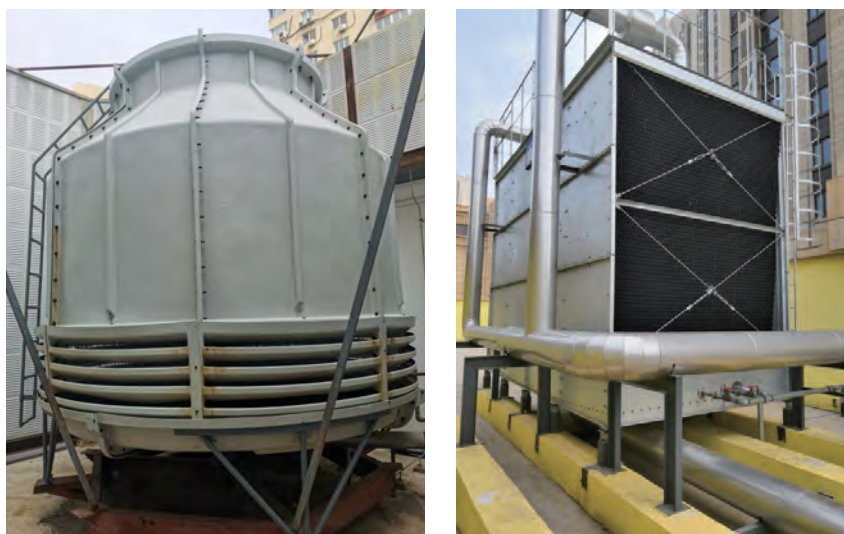
(a) 圆形逆流式冷却塔
