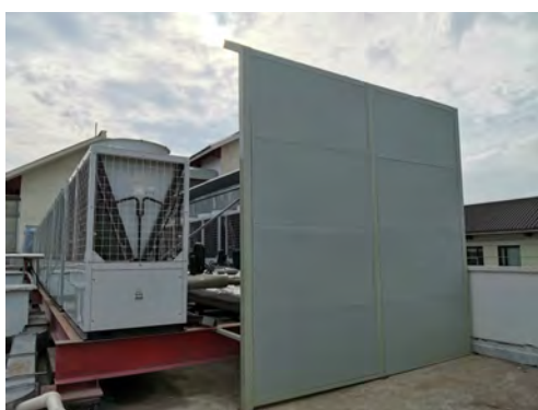
(a) 风冷机组隔声屏障
