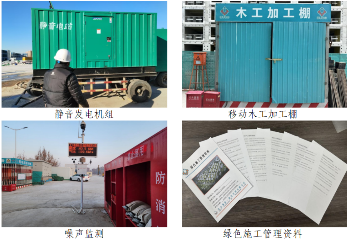
图 3 大兴区三合庄改造施工噪声治理措施
