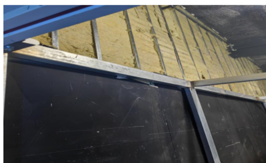
内部墙面控制室内混响
