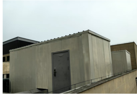
隔音罩建设完成
