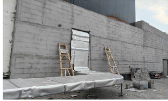
外部管道及外墙强化隔声
