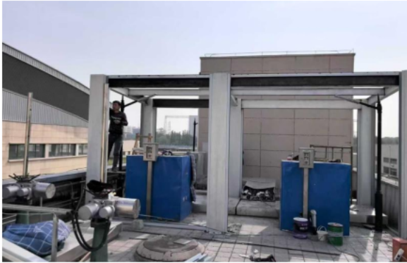
隔音罩建设过程
