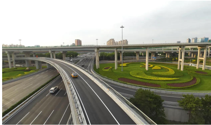
图 4 四环主路路面修复情况
