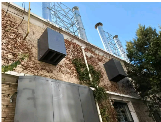
图 2 锅炉房烟囱更换和排风口隔音改造
